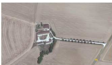
L'ancienne ferme de la rente au Corbeton
