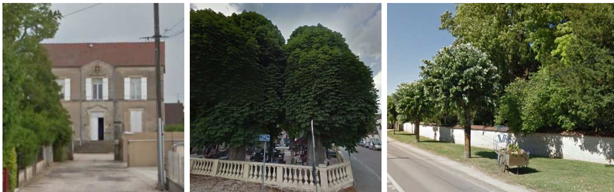
La Cure, les marronniers angle rue de Dijon / rue du Champ de Foire et le mur-enclos angle Genlis/Rigole, source : Google Maps.
