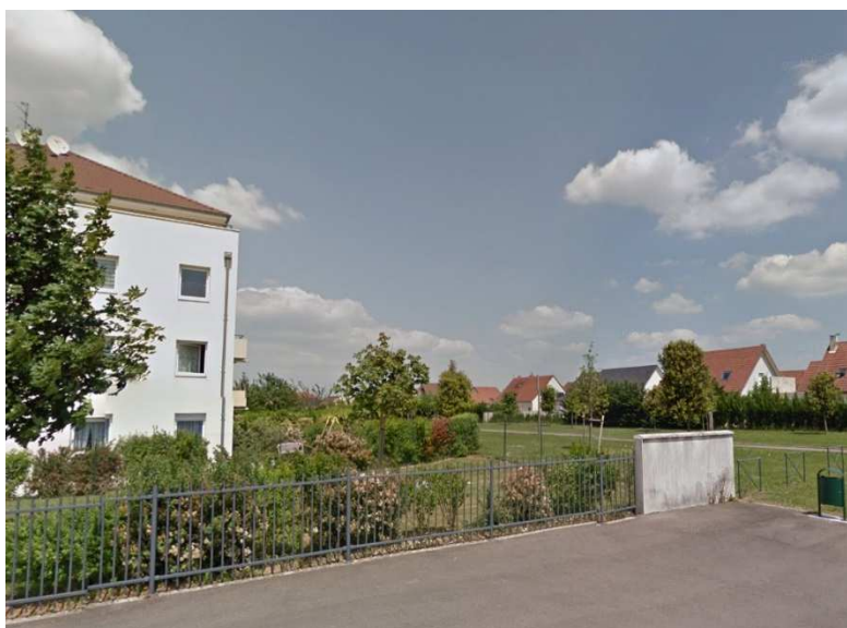
Exemple de clôture en grille pouvant idéalement s'implanter en limite de cheminement piétonnier : grille peu haute, marquée d'un ou plusieurs éléments maçonnés ponctuels pour marquer un angle du lot ou ponctuer le linéaire de clôture si celui-ci est important.
